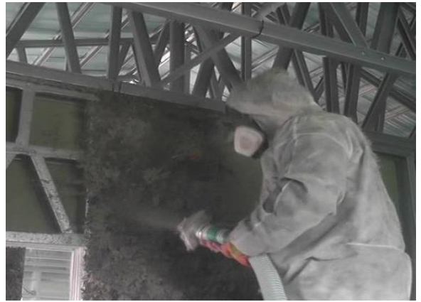
Рис. 3 – Процес утеплення металевобудинку, не гранульованою ізоляцією із БСТВ, методом вологого пневматичного укладання.
