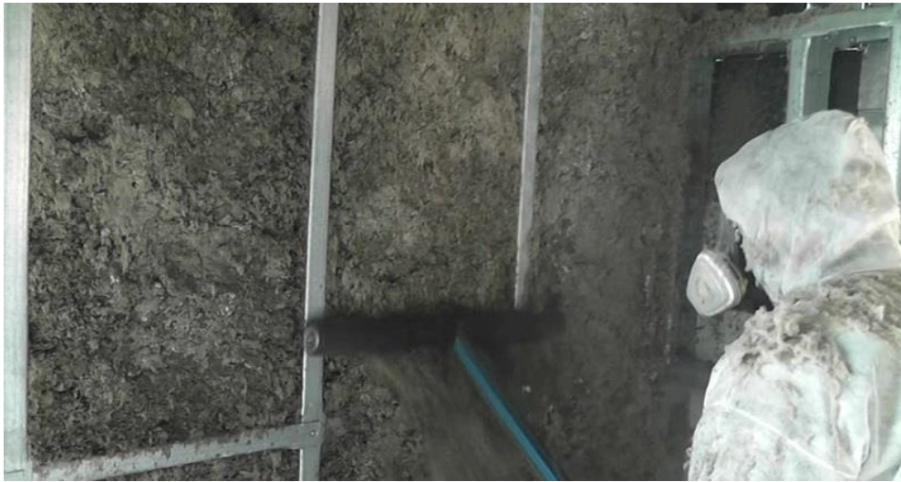
Рисунок 3.4 – Процес видалення надлишкового волокна ротаційним різакром.
