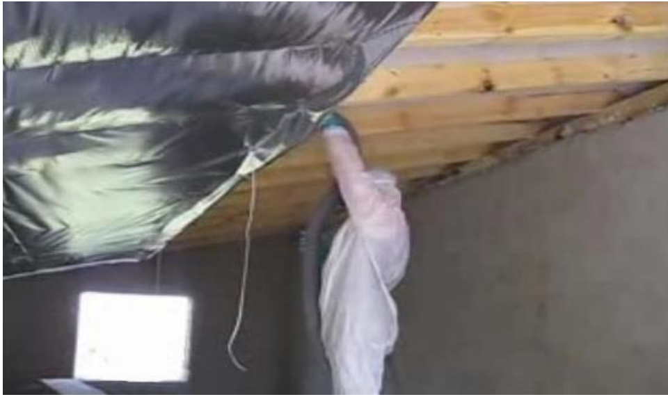
Рисунок 3.6 – Процес утеплення покрівлі мансардного приміщення методом сухого пневматичного укладання суміші з гранульованого БСТВ та негранульованого БСТВ.
