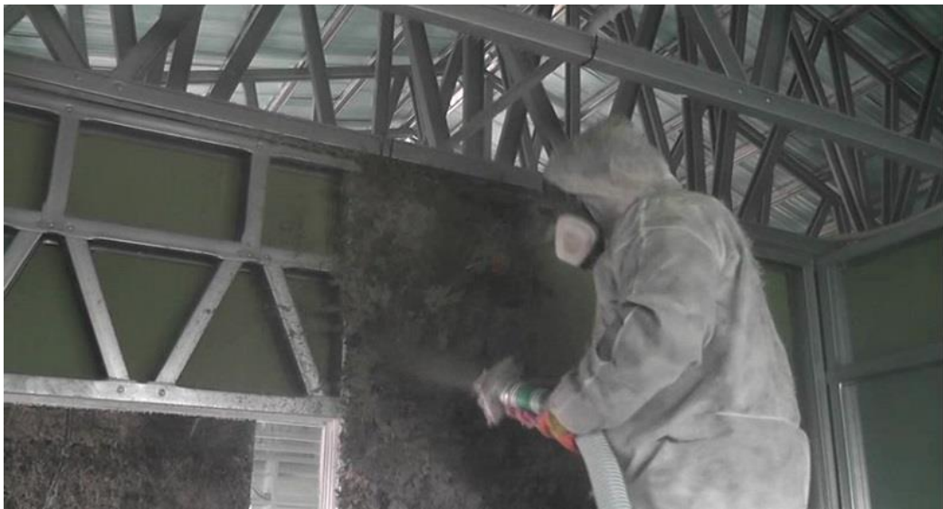
Рисунок 3.3 – Процес утеплення металево-каркасного будинку, не гранульованою ізоляцією із БСТВ, методом вологого пневматичного укладання.
