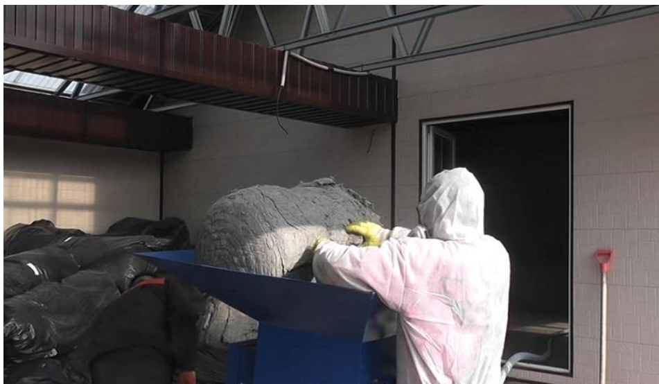
Рисунок 3.7 – Процес завантаження рулону ізоляційного матеріалу з БСТВ у бункер пневматичного укладача KRENDL450.
