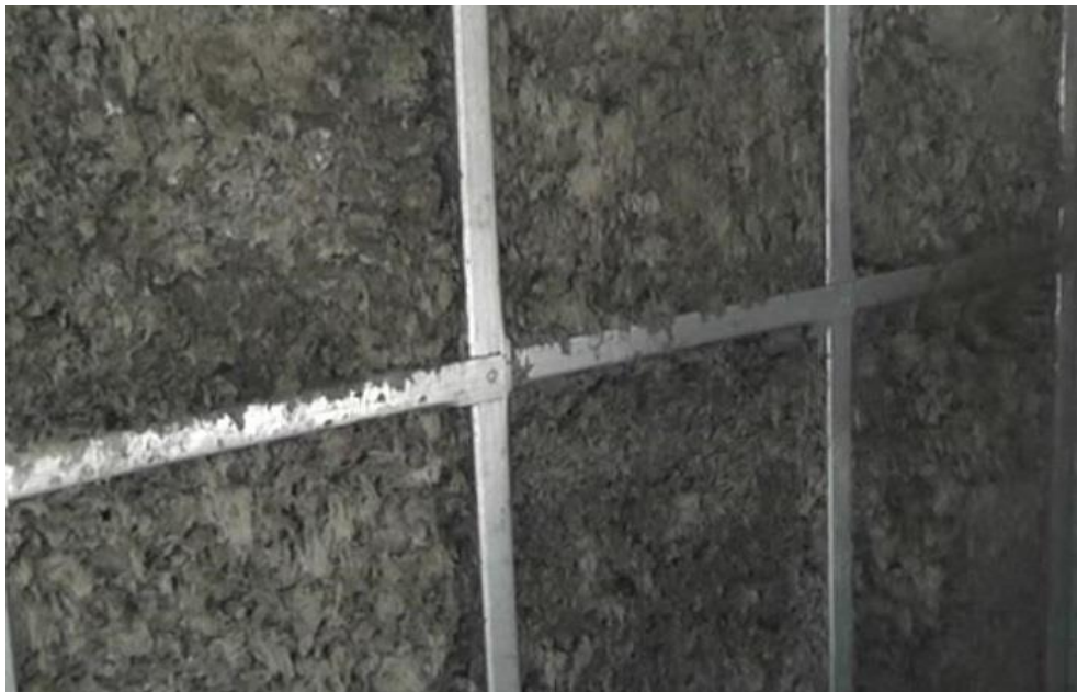
Рисунок 3.5 – Фрагмент сталевий каркасної стіни ізолюваної методом волого пневматичного укладання.
